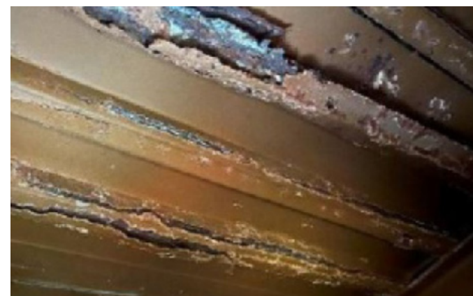
I solai della Biblioteca provinciale che saranno oggetto di restyling
